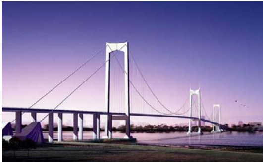
图 2-17 泰州长江大桥
