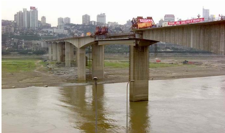
图 2-7 重庆石板坡钢箱梁整体吊装过程
